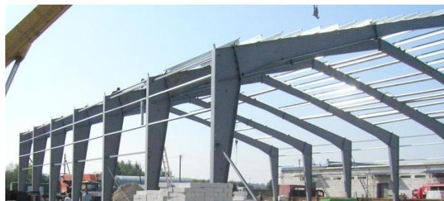
**№4.** Монтаж рам с шагом 6 метров. Горизонтальную жёсткость рам обеспечивает прогонная часть (оцинкованные профили) и диагональные связи.
