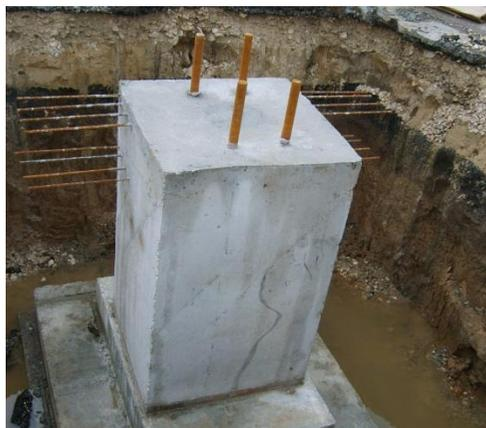
**№2.** Точечный фундамент с четырьмя анкерными болтами, на которые опускается рама.
